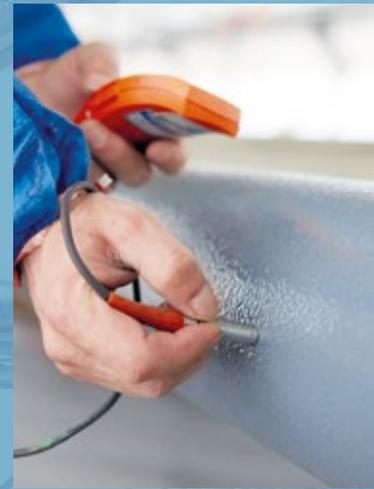
Der letzte Schritt des Loctite® Composite Reparatursystems ist das Auftragen von Loctite® PC 7255 als Korrosionsschutz
