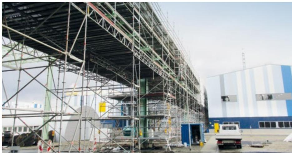
In drei Teilabschnitten wurden 1.900 Quadratmeter Stahlkonstruktion, 800 Quadratmeter Rohre, rund 300 Rohrlager und 750 Rohrbügel beschichtet
