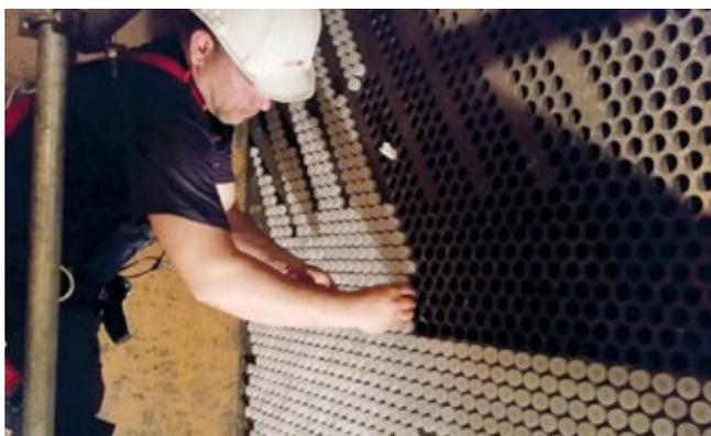
Bevor der Rohrboden neu beschichtet werden kann, werden die Rohre durch Stopfen verschlossen
