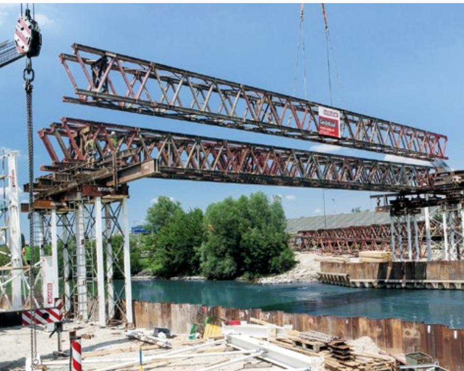
Die Erdberger Brücke über den Donaukanal musste im Zuge der Arbeiten komplett abgerissen und neu errichtet werden
