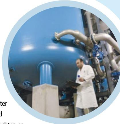
Ohne Unterbrechung des Wasseraufbereitungsprozesses erfolgte der Entkalkungs- bzw. Reinigungsprozess der Reaktoren
